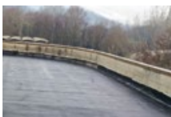
Sistema impermeabilizante bituminoso sobre viejas membranas
